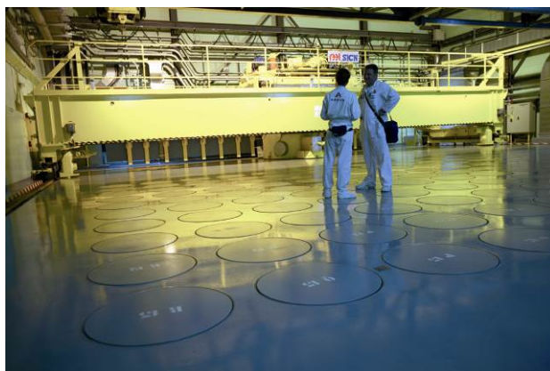
Figure 7 : Entreposage de colis CSD-V - Orano la Hague
