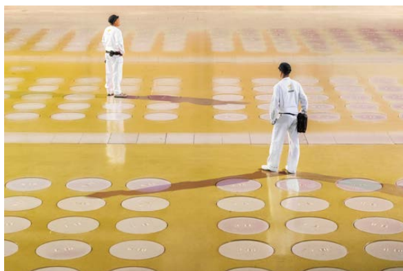
Figure 7 : Entreposage de colis CSD-V - Orano la Hague
