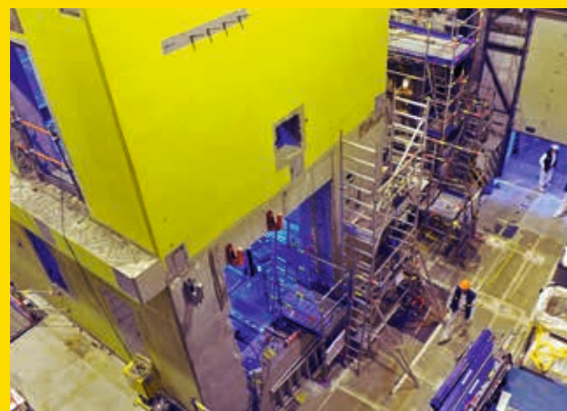
Cellule de RCD en cours de construction
