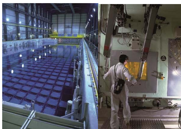
Figure 6 : Piscine d'entreposage et déchargement des combustibles à Orano la Hague
