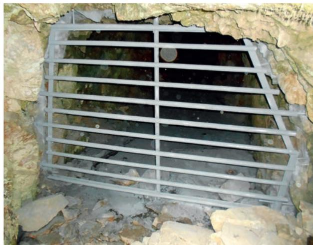
La grille permet de sécuriser l'entrée d'une ancienne galerie, adaptée à la taille des chauves-souris
