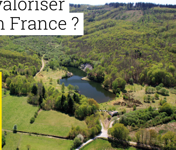
Mine à ciel ouvert du Puy de l'Age réaménagée (Limousin, France)
