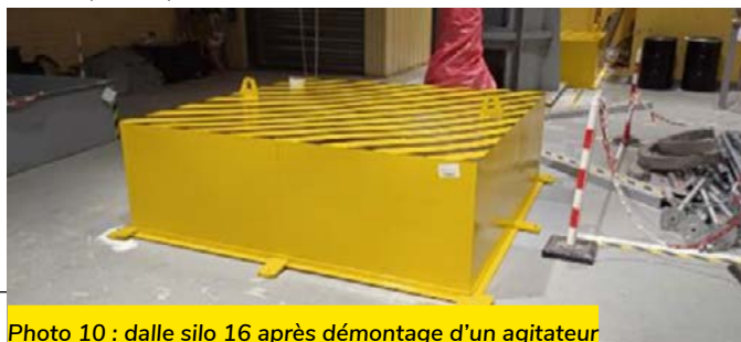
Photo 10 : dalle silo 16 après démontage d'un agitateur
