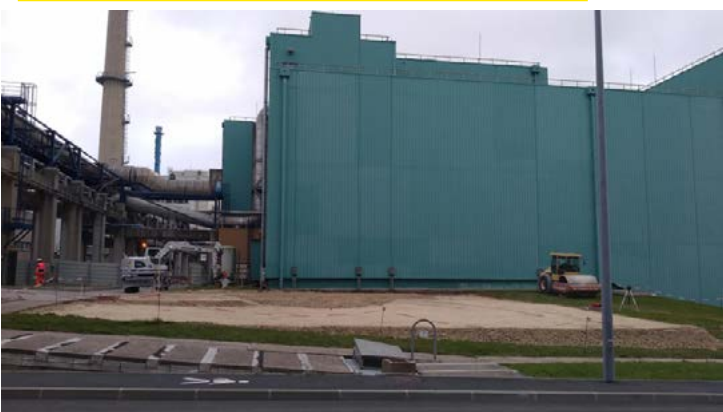
Photo 16 : future implantation de la base vie chantier DFG
