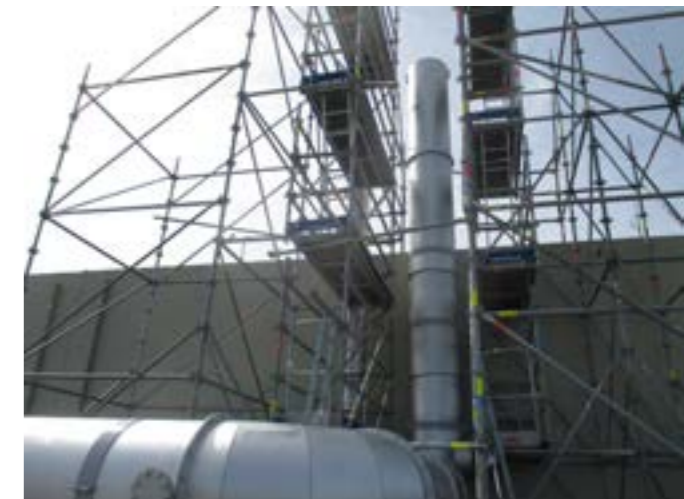
Photo 7 : montage de la cheminée en toit de silo
