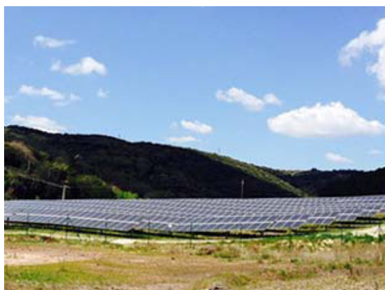
Centrale solaire de Lodève (Le Bosc)
